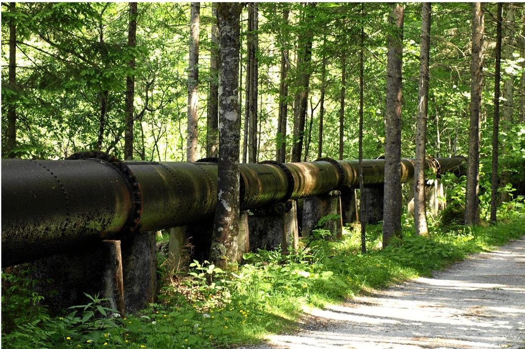
Von der Quelle führt eine Druckleitung zum eigenen Elektrizitätswerk das 1909 erbaut wurde. Das Wasser treibt 2 Francis – Spiralturbinen mit einer Gesamtleistung von 416 kW.
